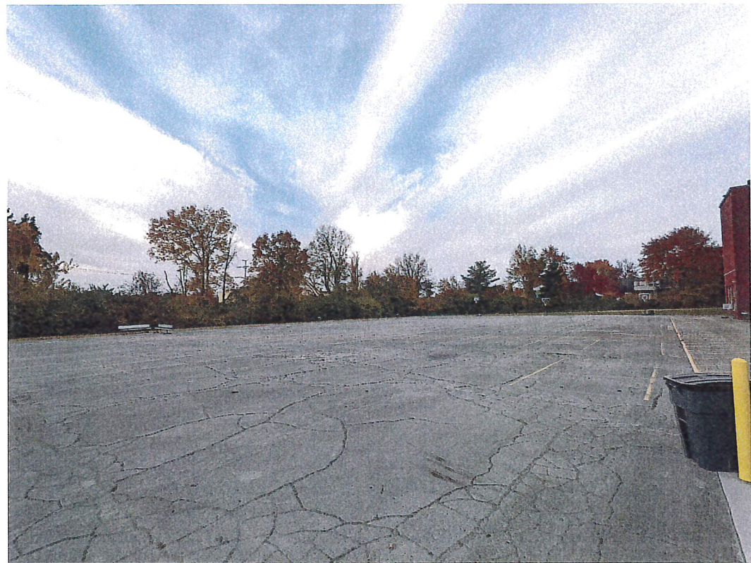
GRADE LEVEL SITE PHOTO SCALE: N.T.S.
